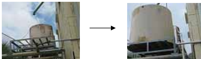
雨水タンクを 1 基から 3 基へ増設
